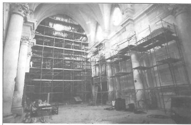
L'interno della Chiesa durante i lavori
